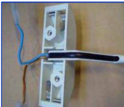
Rys. 2: Ułożenie kabla w stacji ładowania
